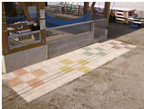
インターロッキング完成
