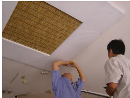
建築部の手製の木枠で補修
