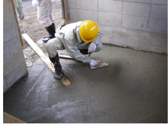
一輪車小屋へのコンクリート打設
