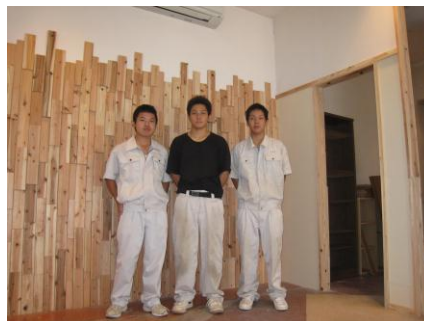
壁に木レンガを設置
