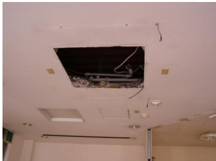
天井部分のエアコン跡
